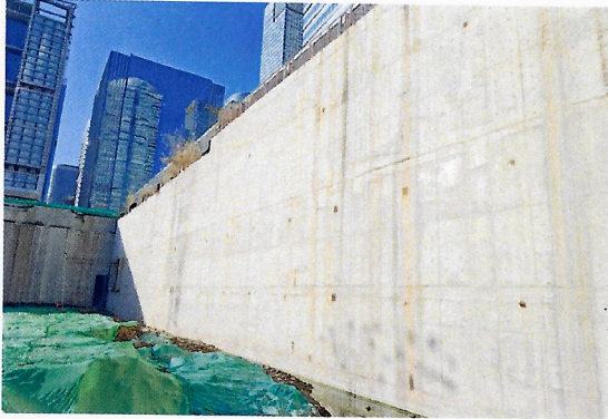
项目北侧加固坎
