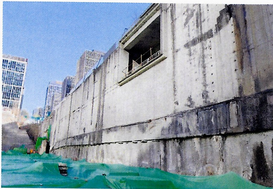
项目南侧加固坎
